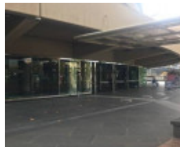
2019_Hamer Hall entrance.jpg
